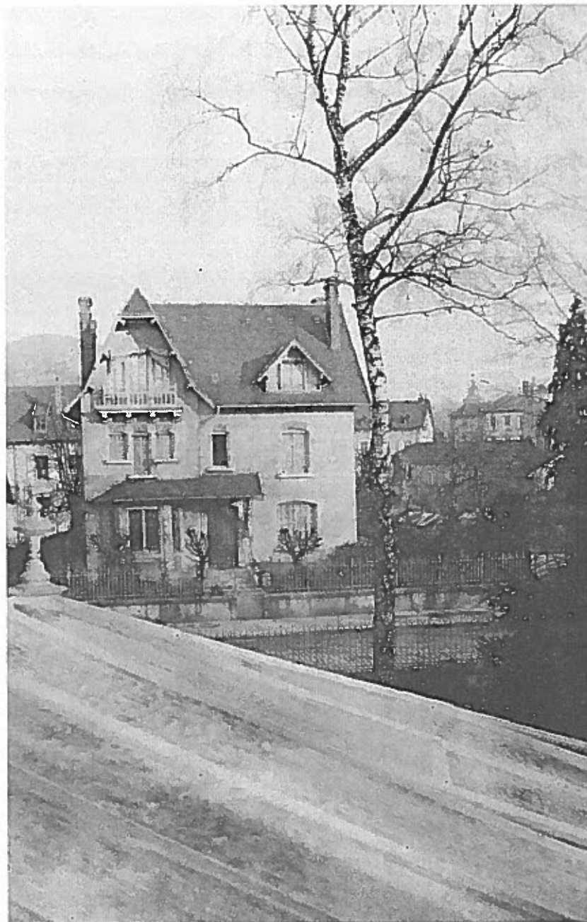
Notre maison, rue des Trois Villes à Saint Dié avant novembre 1944.
